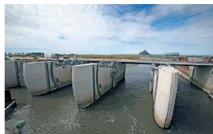
Les piles du barrage, en béton brut lisse, sont dimensionnées pour conserver finesse et élégance. Côté Couesnon, elles forment des proues effilées dont la partie supérieure recueille l'effort horizontal de poussée des vérins. Côté mer, elles reprennent les consoles métalliques qui supportent le balcon maritime.
